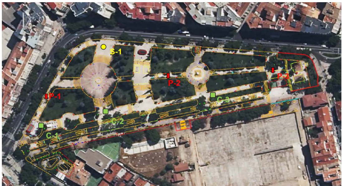
Figura 5. Ortofoto previo a la demolición de las naves y replanteo de los ensayos.
