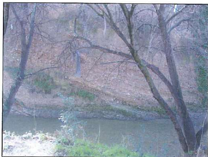
Fotografía 16.- Gravas cementadas en zona de pasarela desde calle Manuel Lasala.
