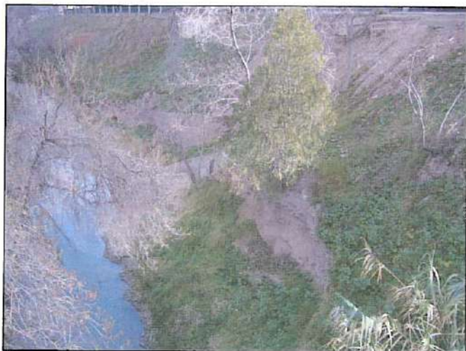
Fotografía 7.- Puente de los Gitanos. Las gravas aluviales afloran bajo 2/3 de talud en rellenos.
