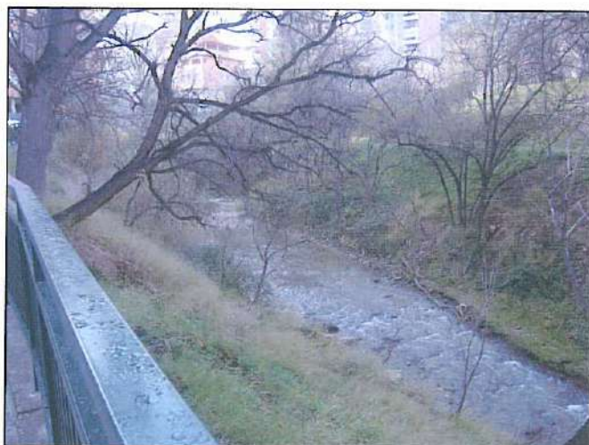
Fotografía 10.- Calle Río Huerva. El talud está contenido por muros antiguos y rellenos poco consolidados.
