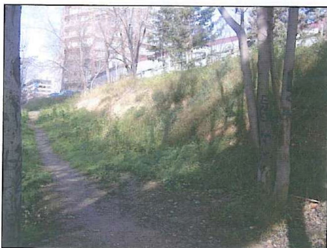
Fotografía 17.- Rellenos que enlazan la calle Manuel Lasala con los jardines y zona baja.
