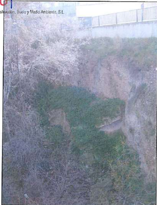
Fotografía 13.- Pasarela peatonal en C/ Marina española con gravas cementadas y rellenos al pie.
