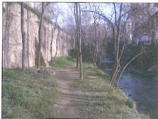
Fotografía 20.- Muro de contención en la margen izquierda bajo calle Manuel Lasala.
