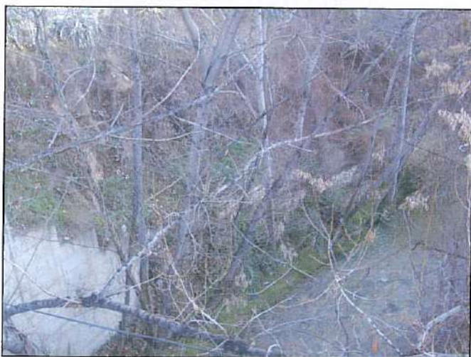
Fotografía 15.- Defensas de gaviones en la margen izquierda justo bajo el puente de Ruiseñores
