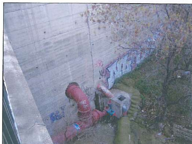
Fotografía 4.- Puente Avenida Goya. Margen derecha. La posición de las tuberías podría indicar el nivel de rellenos en el trasdós del muro.
