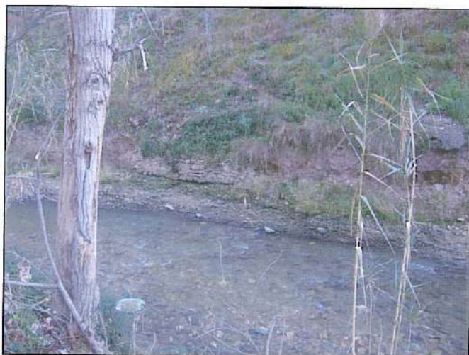
Fotografía 21.- Antiguos muros que llegan hasta el mismo cauce en la calle Genoveva Torres.
