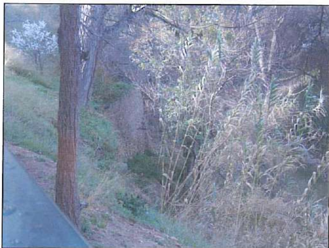
Fotografía 11.- Calle Río Huerva. La margen derecha se verticaliza gracias a la presencia de gravas cementadas.
