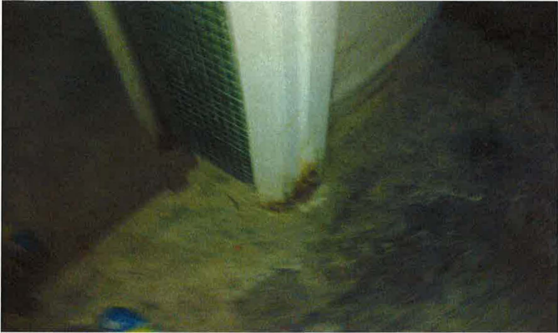
Reparación carpintería interior y alicatado gresite
