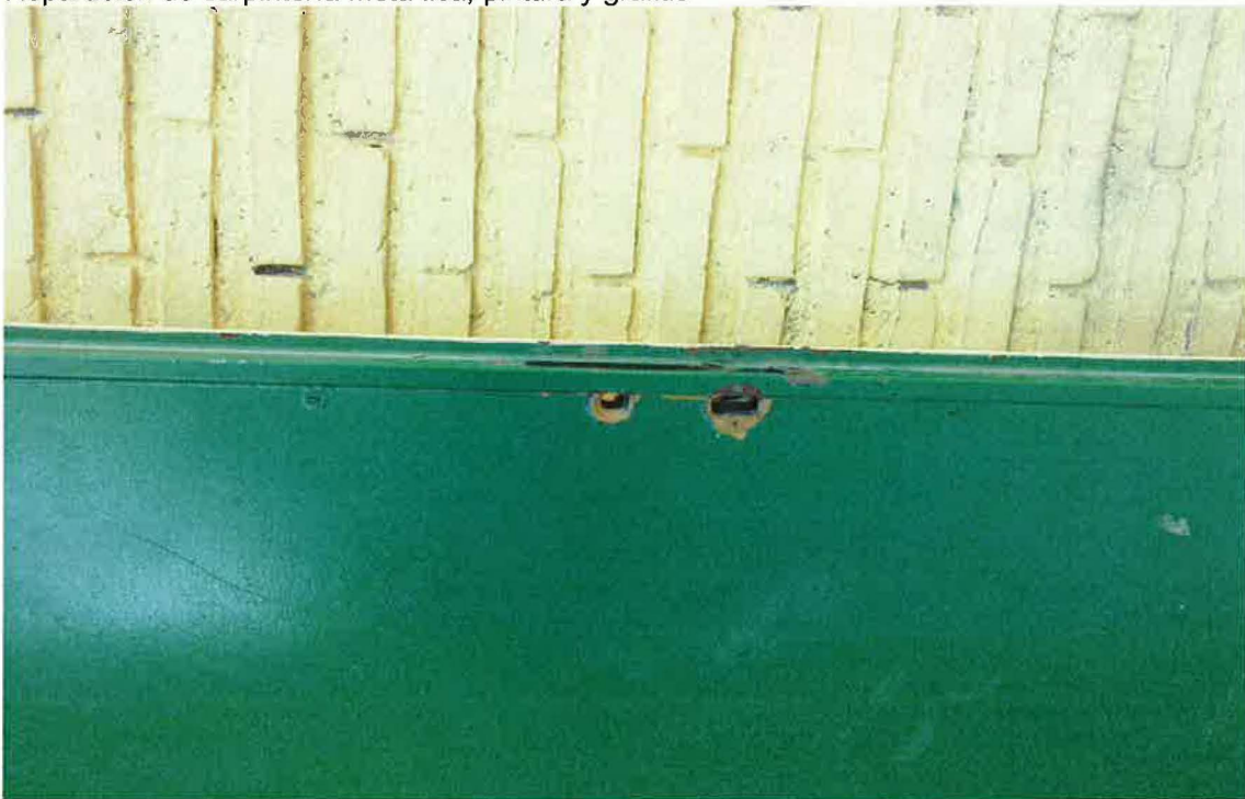
Reparación carpintería exterior
