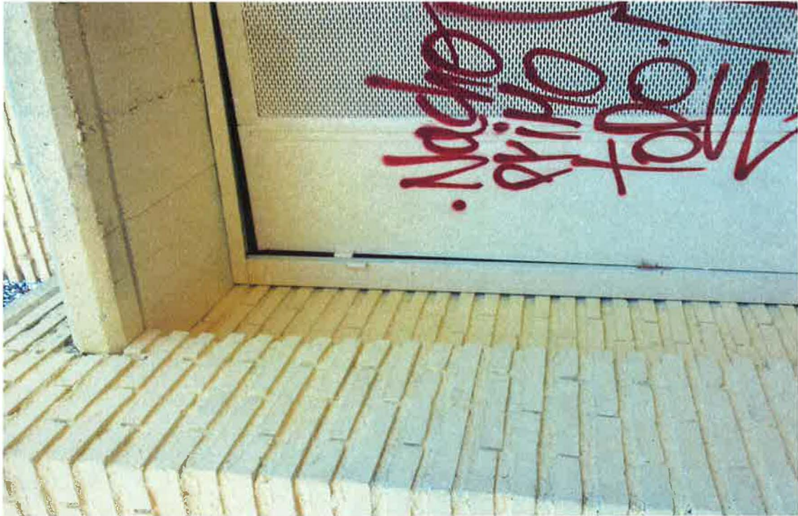
Reparación de carpintería meta'lica, pintura y grafitis
