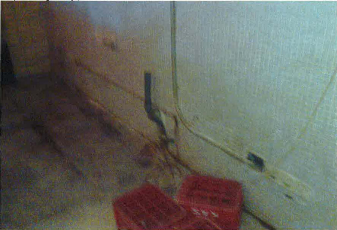
Revisión instalación eléctrica y fontanería
