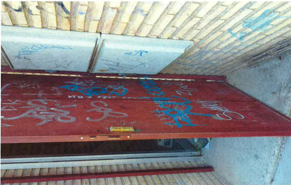
Limpieza de grafitis y pintura exterior
