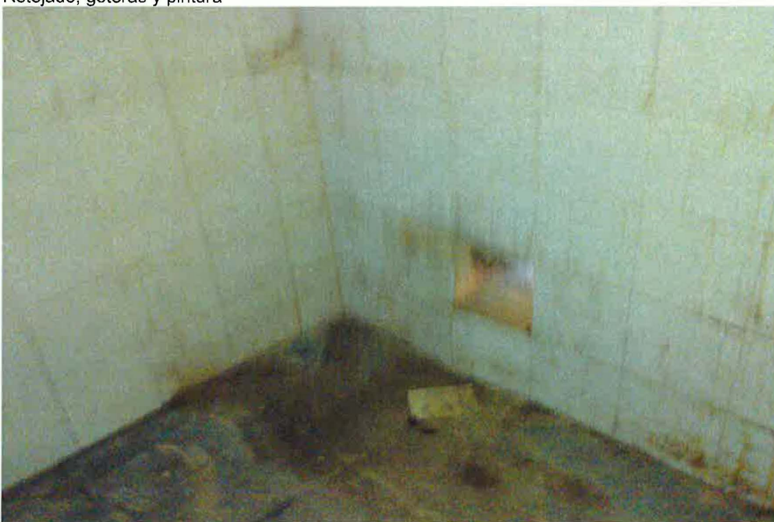
Limpieza y alicatados
