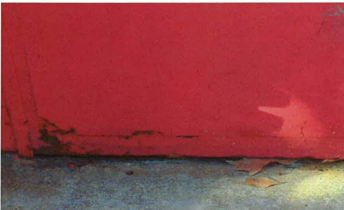
Reparación de carpintería metálica exterior
