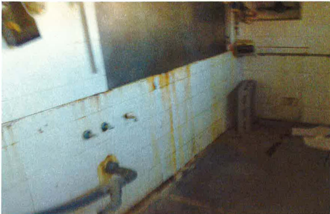
Limpieza, alicatados, instalación de fontanería
