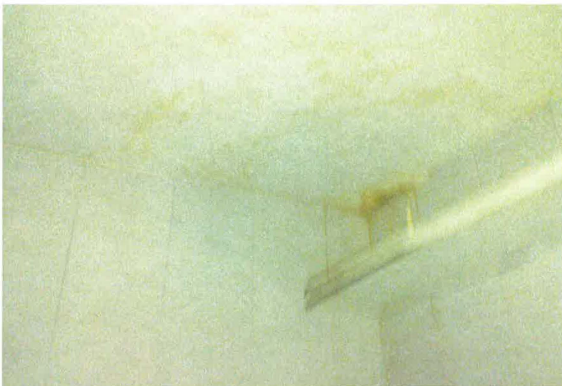
Retejado, goteras y pintura
