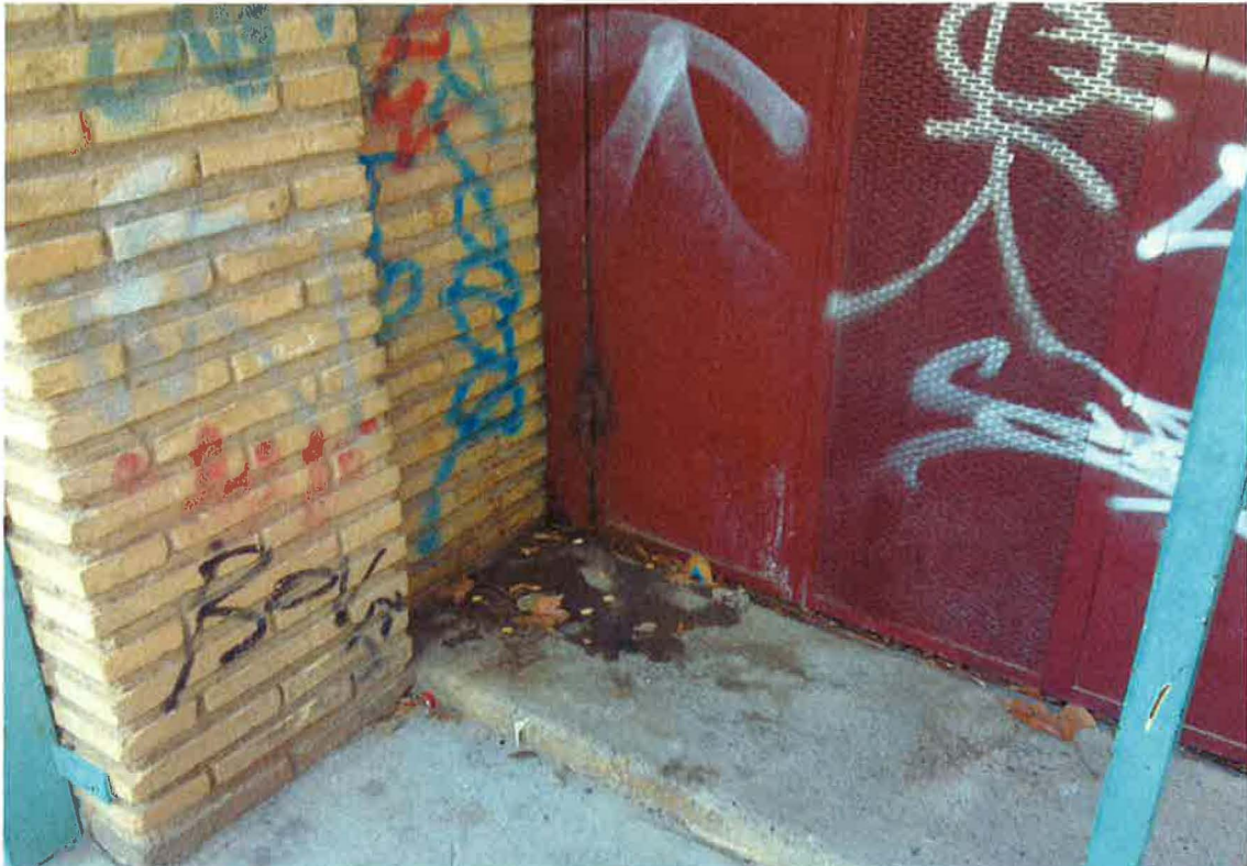
Reparación de carpintería exterior, pintura y grafitis
