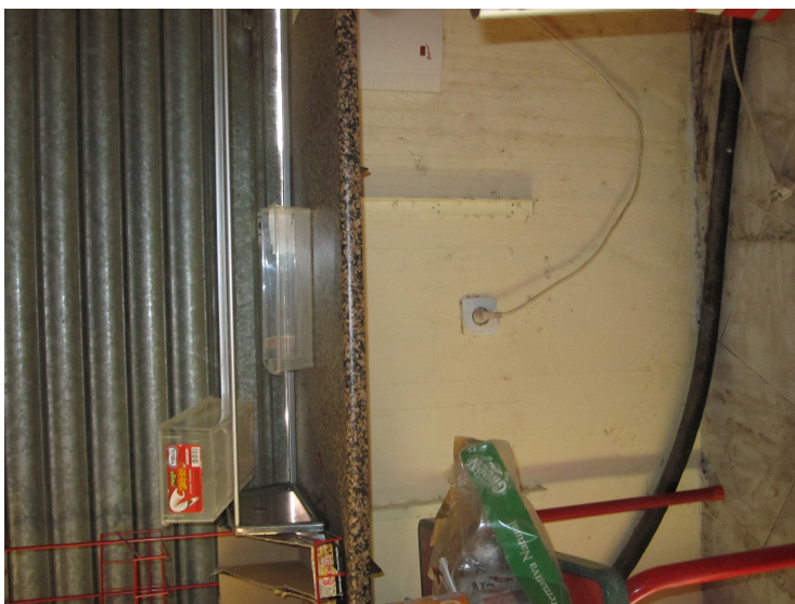
(058) – LIMPIEZA Y PINTADO INTERIOR
