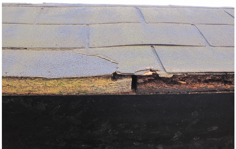
(052) – IMPERMEABILIZACIÓN ROTA (1)
