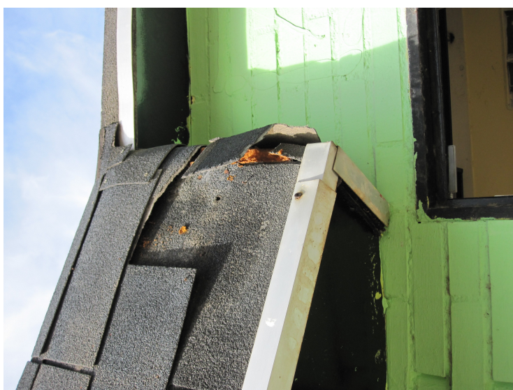
(055) – IMPERMEABILIZACIÓN ROTA (5)
