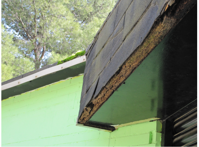
(065) – FALDÓN DESCOMPUESTO (3)
