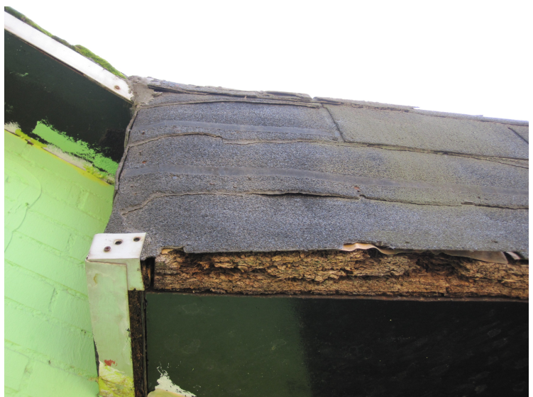
(051) – FALDÓN DESCOMPUESTO (1)
