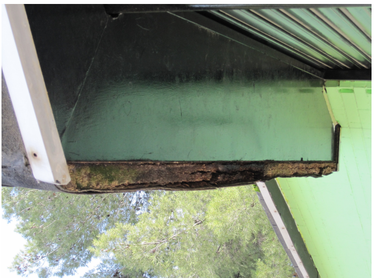
(064) – FALDÓN DESCOMPUESTO (2)
