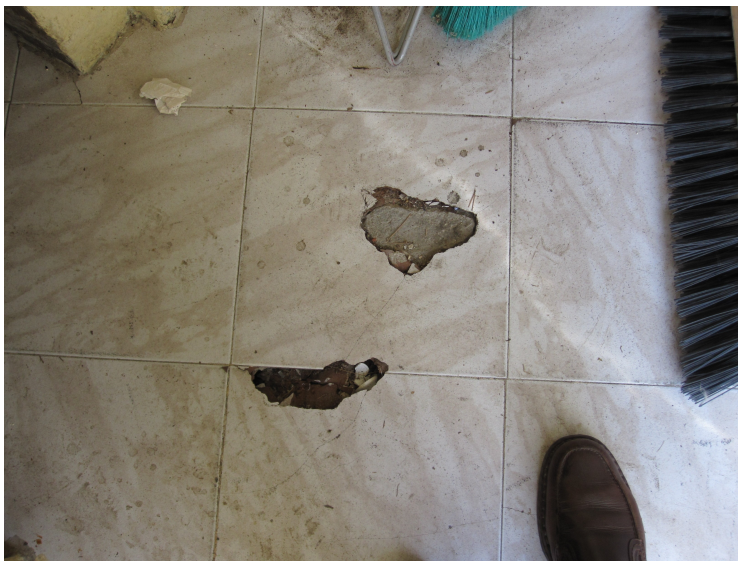
(056) – ROTURA PAVIMENTO
