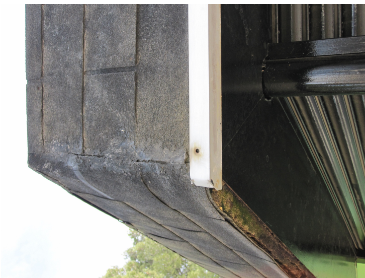
(054) – IMPERMEABILIZACIÓN ROTA (3)
