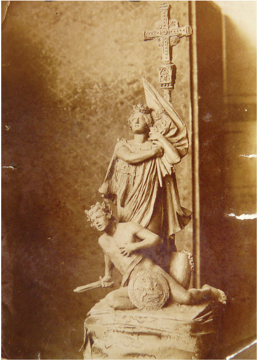
Boceto para el monumento a los Mártires de la Religión y la Patria, 1898
