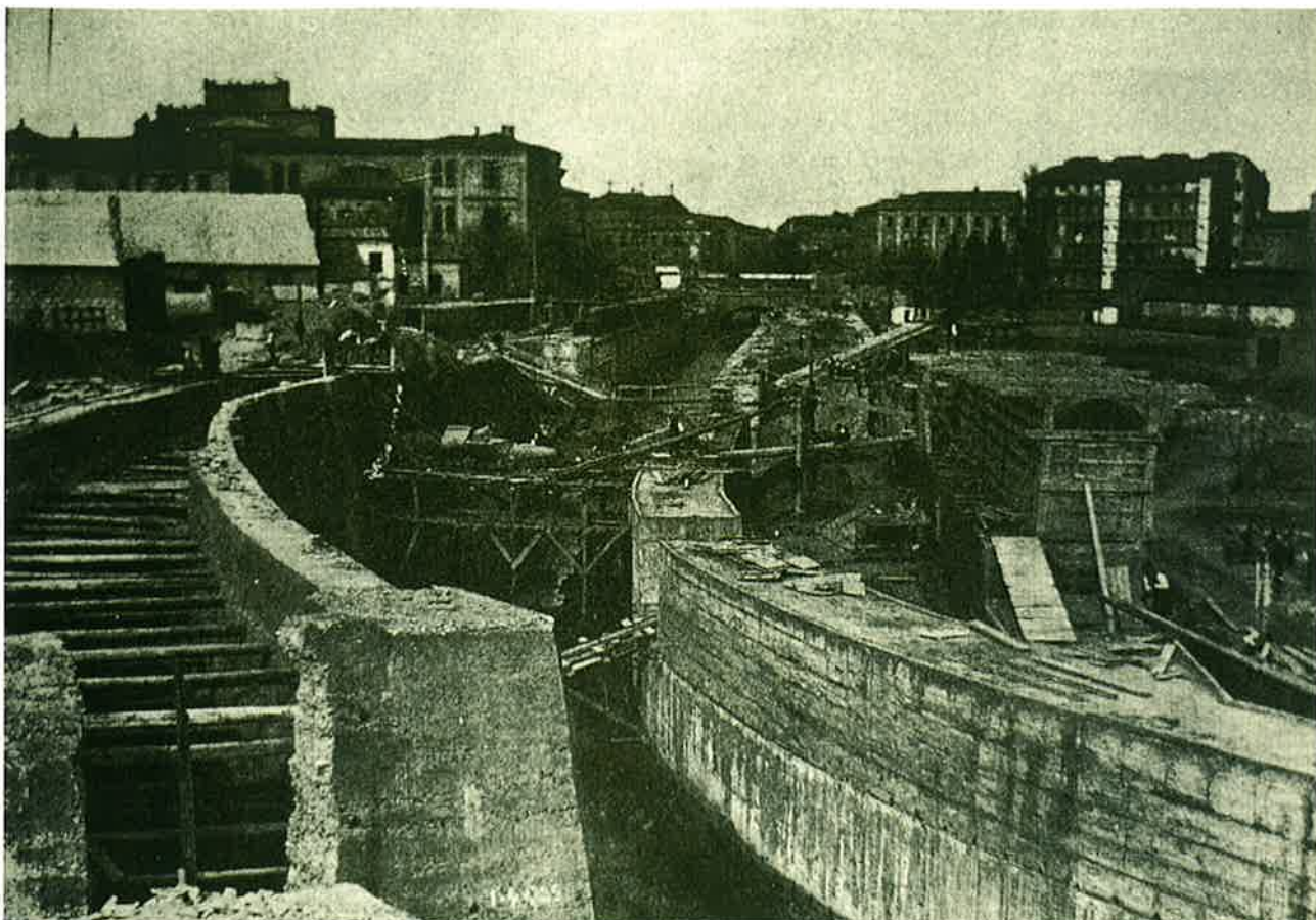
Obras de cubrimiento del río Huerva, 1925
