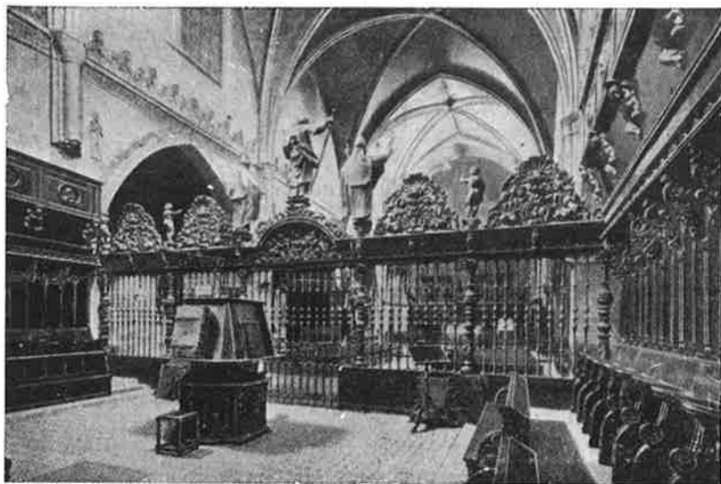
Iglesia de San Pablo. Interior del coro Eglise Saint Paul. Interieur du chœur Church of San Pablo. Interior of the choir
