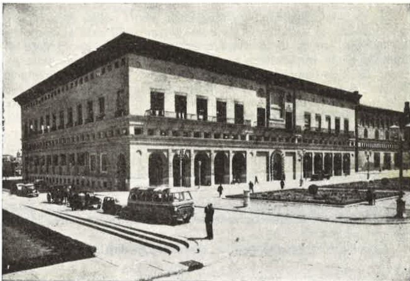
Casa Consistorial Maison de la Ville City Hall
