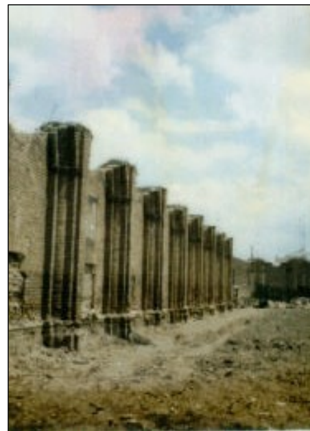
RESTOS DEL CLAUSTRO
