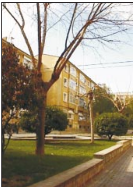
GRUPO DE VIVIENDAS PUENTE VIRREY
