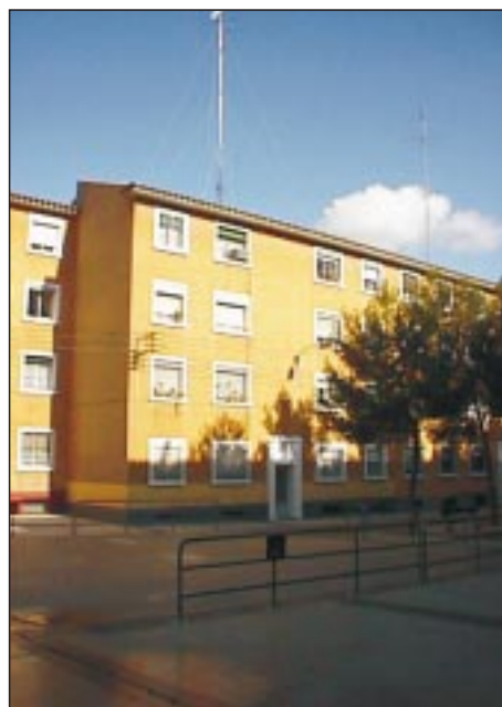
GRUPO DE VIVIENDAS PUENTE VIRREY
