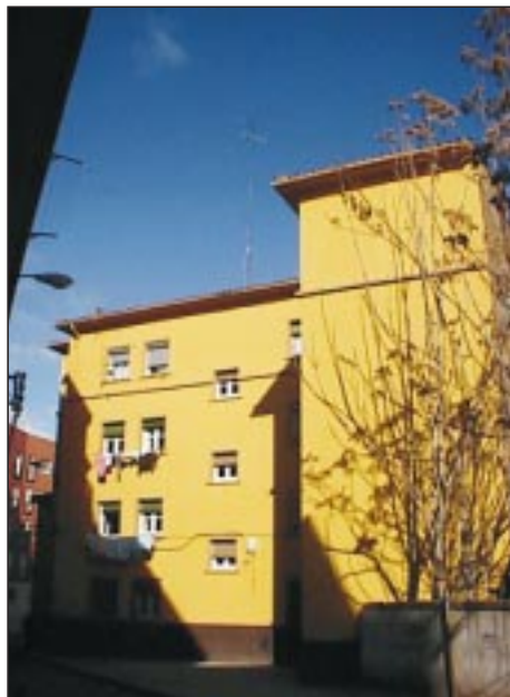
GRUPO DE VIVIENDAS PUENTE VIRREY
