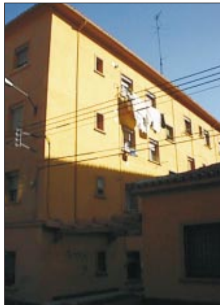
GRUPO DE VIVIENDAS PUENTE VIRREY
