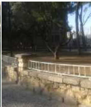
Muro Parque Pignatelli
