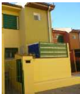
Pintura de fachadas
