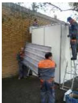
Reparación de casetas
