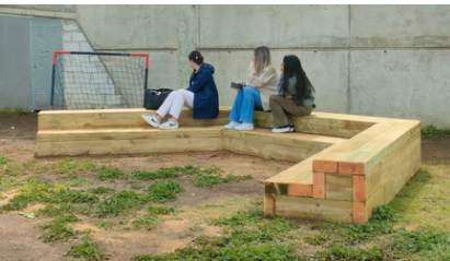
Vigas de pino tratado autoclave (diam. 3-4 m )
