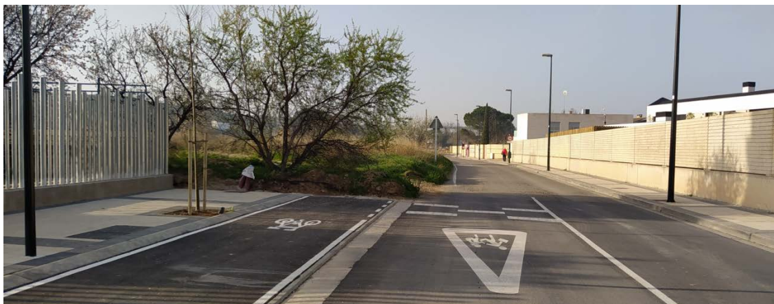
Imagen: Estado actual de las obras ejecutadas frente al colegio Liceo Europa
