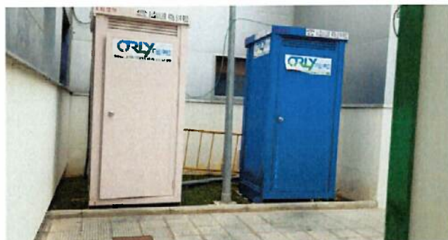
Baños portátiles instalados en la zona exterior anexa a las Urgencias del Royo Villanova. I HA
