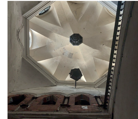
Bóveda de la caja de escaleras.
