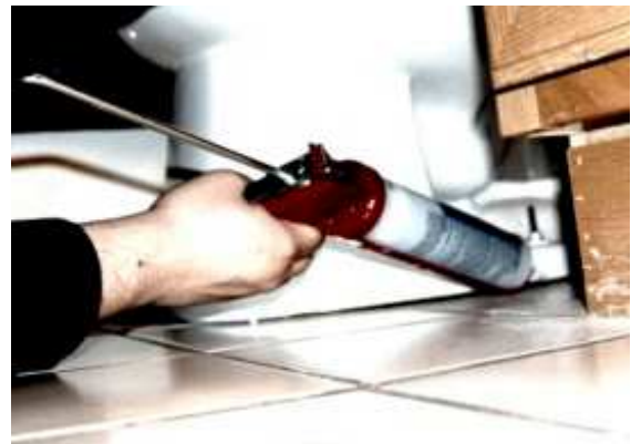
Selle con silicona grietas y rendijas
