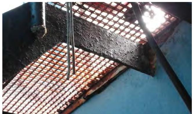
El paso del tiempo, así como el ambiente de gran humedad y la existencia de efluvios ácidos de los componentes de depuración (ácido clorhídrico) han hecho que la protección de la pintura haya desaparecido en zonas puntuales, afectando severamente a los elementos metálicos, en particular al apoyo de las zancas de la escalera en el suelo.
