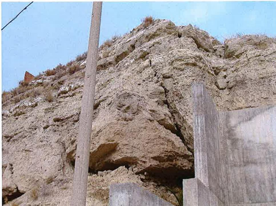
Foto nº 10. Vista del resalte superior en el extremo oriental de la ladera. Diaclasas muy abiertas y riesgo de desprendimiento (Bloque C)
