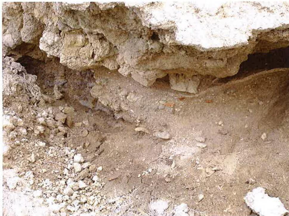
Foto nº 6. Detalle del apoyo del mismo bloque sobre rellenos
