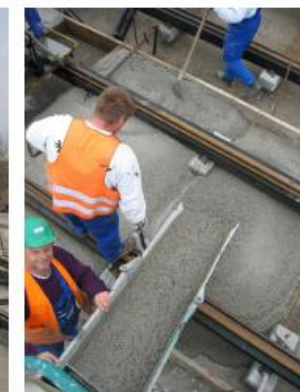
Ilustración 19. Sistema de vía clásico con apoyo continuo. Hormigonado
