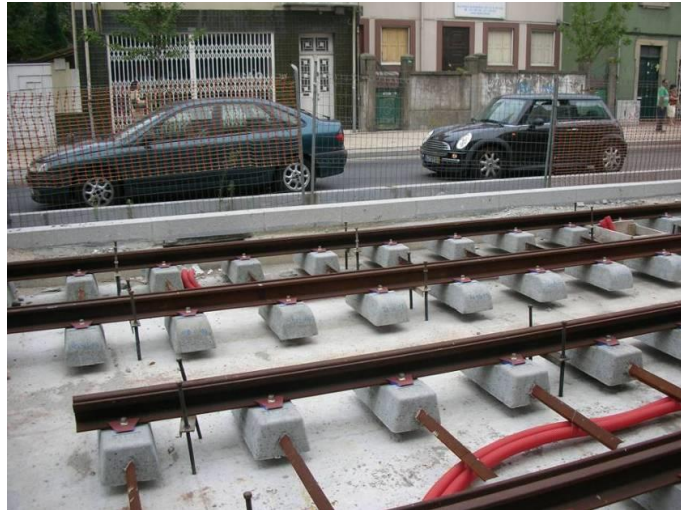
Ilustración 13. Montaje superestructura Tranvía de Oporto. Detalle de husillos para nivelación
