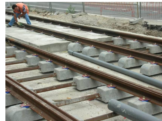
Ilustración 12. Montaje superestructura Tranvía de Oporto
