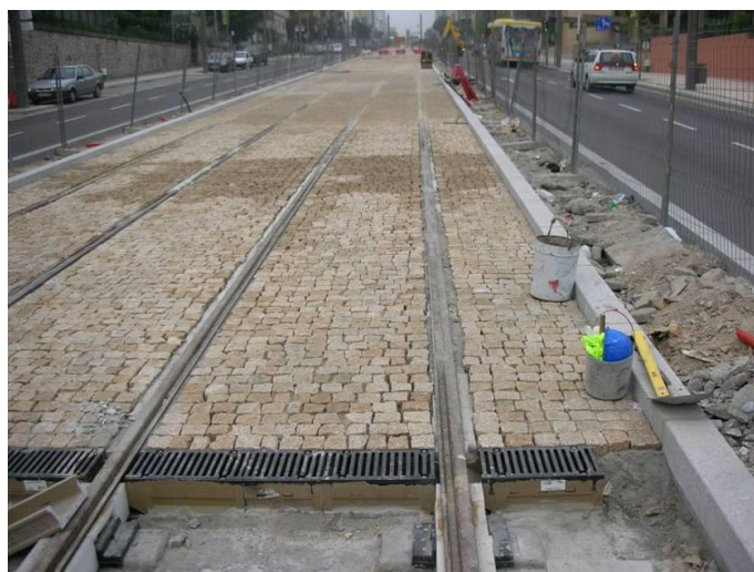
Ilustración 14. Tranvía de Oporto. Detalle de pavimentación de plataforma
