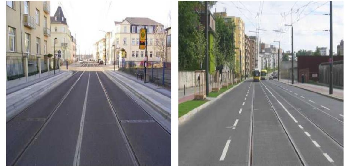
Ilustración 23. Sistema de vía clásico con apoyo continuo. Izquierda: Dresden (Alemania). Derecha: Berlín (Alemania)
