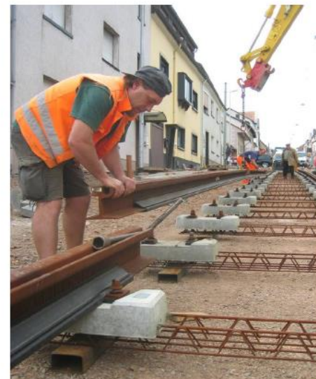
Ilustración 18. Sistema de vía clásico con apoyo continuo. Instalación de vía
