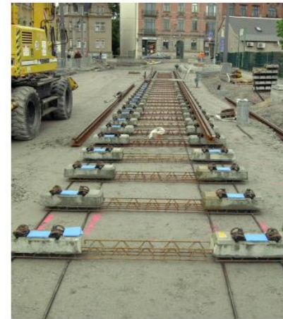
Ilustración 17. Sistema de vía clásico con apoyo continuo. Colocación de traviesas
