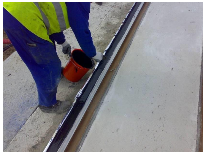
Ilustración 30. Detalle vertido de Corkelast
