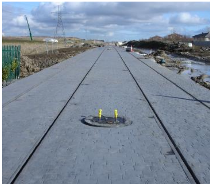
Ilustración 22. Sistema de vía clásico con apoyo continuo. Acabado en hormigón impreso
