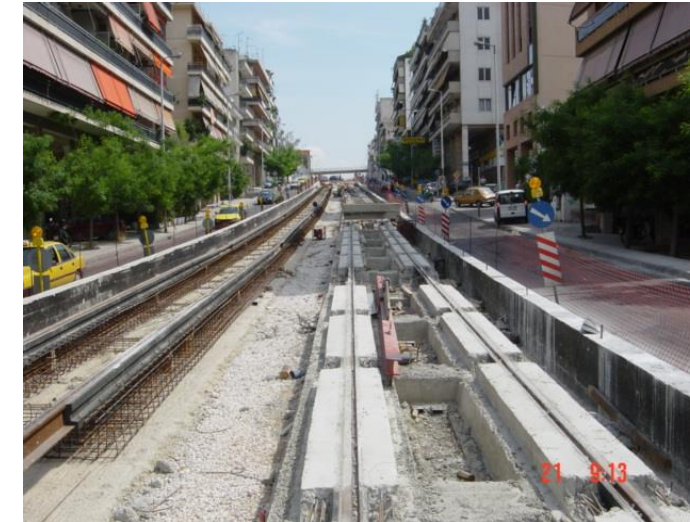
Ilustración 37. Sección vía embebida con carril pre-revestido. Tranvía de Atenas. Montaje de superestructura
