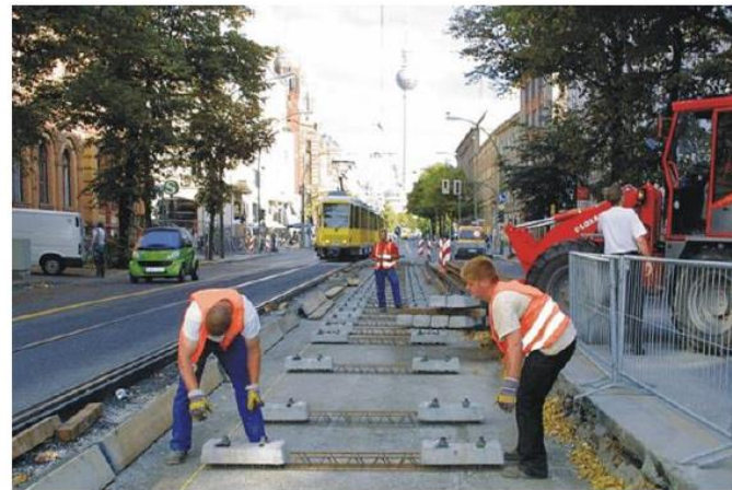
Ilustración 17. Sistema de vía clásico con apoyo continuo. Colocación de traviesas
