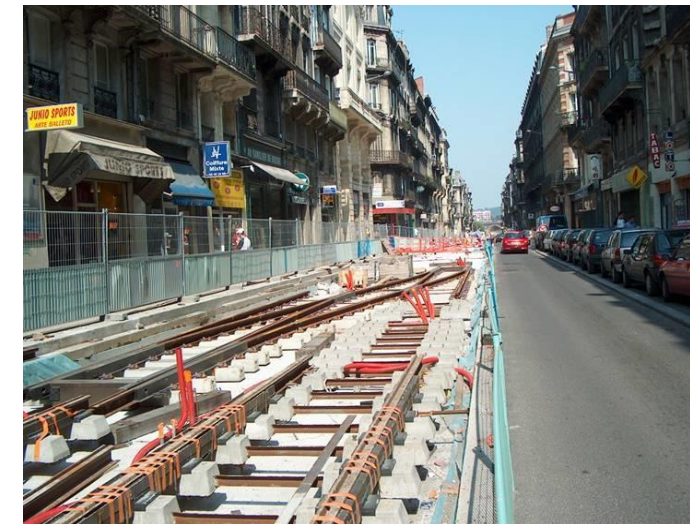
Ilustración 11. Montaje superestructura Tranvía de Burdeos
