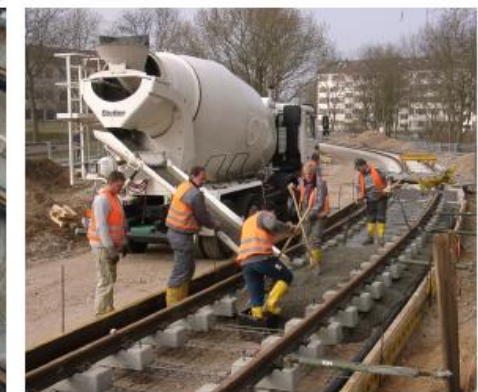
Ilustración 19. Sistema de vía clásico con apoyo continuo. Hormigonado
