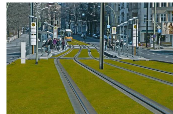
Ilustración 20. Sistema de vía clásico con apoyo continuo. Acabado en césped artificial
