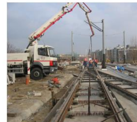
Ilustración 19. Sistema de vía clásico con apoyo continuo. Hormigonado
