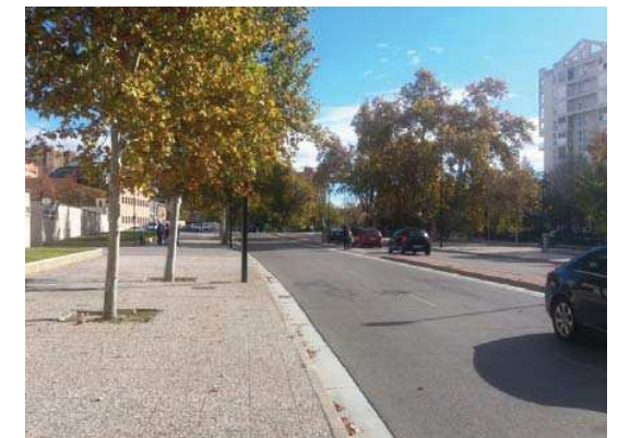
Final del trazado en paseo del Canal, sobre el nivel de terraza E
