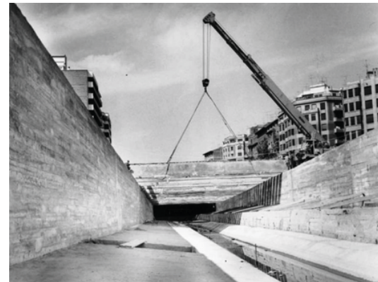
Obras del cubrimiento del Huerva al final del paseo de la Constitución en 1969
