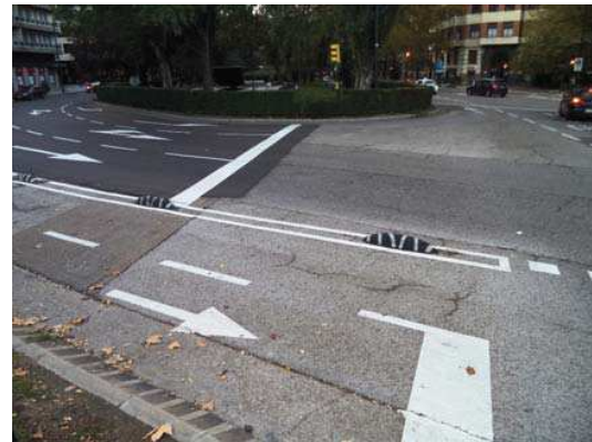
Zona de paso sobre el cubrimiento del Huerva en el giro al final del paseo de la Constitución
