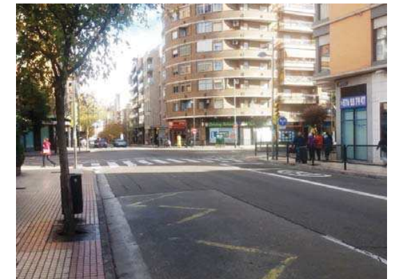
Avda. San José. Zona de paso sobre el cubrimiento del ferrocarril de Tenor Fleita
