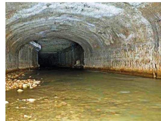
Vista inferior del arco del puente de Santa Engracia en la zona de paso por plaza Paraíso
