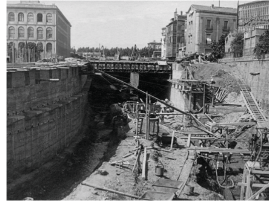
Obras del cubrimiento del Huerva en el paseo de la Constitución a la altura de la calle Juan bruil en 1927
