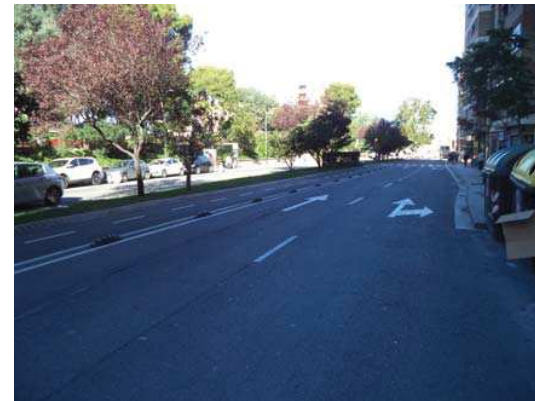
Descenso del nivel de terraza E al nivel F en C/ Rioja
