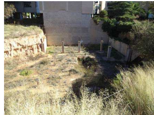
Construcción abandonada por dolina 100 m al este del PK 1+450 (C/ Océano Atlántico)
