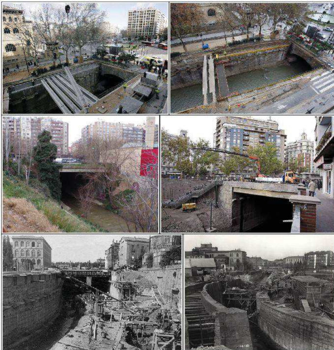
Figura 14.- Fotografías históricas de la construcción del soterramiento del Huerva incluyendo las actuaciones realizadas recientemente con motivo de la renovación de la cubierta en los últimos años (fondo Heraldo de Aragón).
