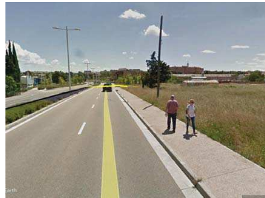
Descenso del nivel de terraza C al nivel E a partir del PK 0+800
