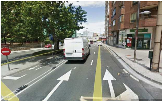
Descenso de "e" a "f" en calle Rioja
