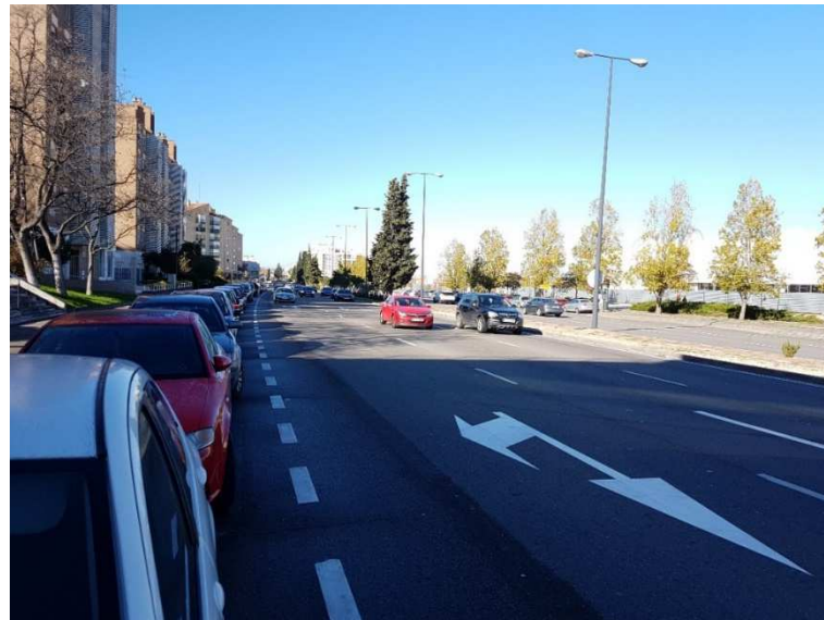
Ilustración 44: Vial Av. Navarra sentido este
