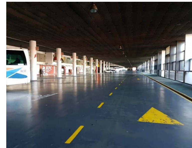
Ilustración 48: Interior de la estación, zona de andenes de autobús
