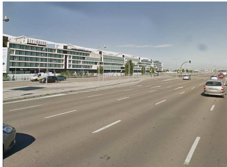
Ilustración 46: Vial Av. Ciudad de Soria sentido oeste, acceso soterrado a estación a la izquierda
