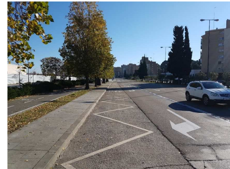
Ilustración 43: Vial Av. Navarra sentido oeste
