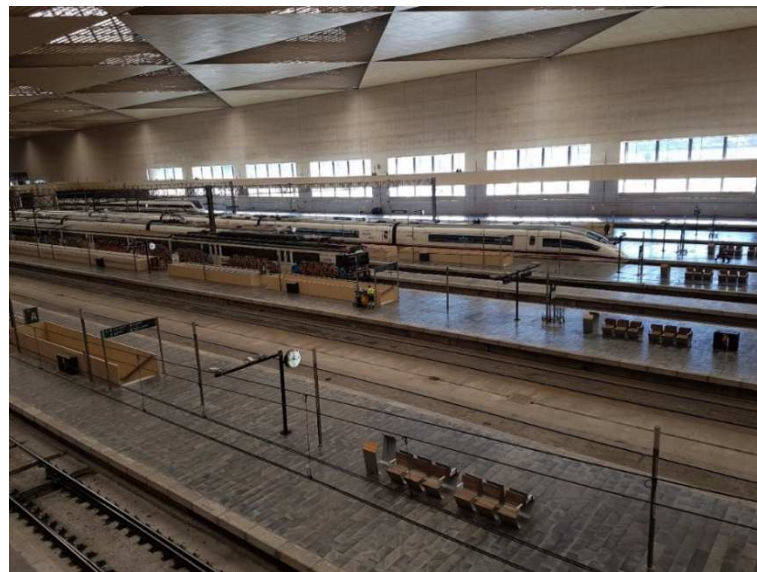
Ilustración 50: Interior de la estación en zona de andenes de tren. Acceso desde túnel inferior
