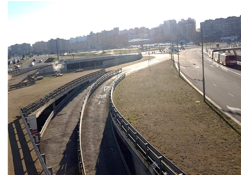
Ilustración 47: Vial de acceso a calle Rioja desde los andenes de la estación de autobuses
