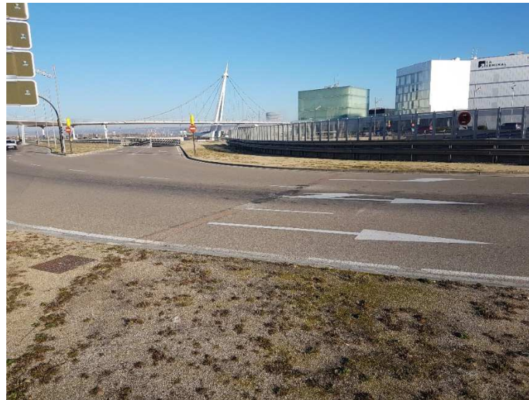
Ilustración 66: Vial de la calle Rioja en zona de la estación
