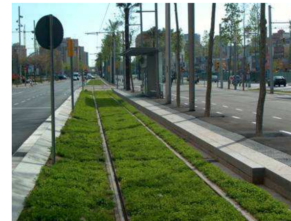
Parada con trazado deprimido en Barcelona
