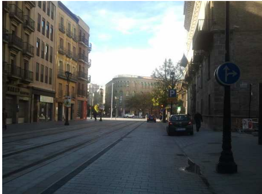
Vial de servicio anexo a la plataforma en El Coso (Línea 1)
