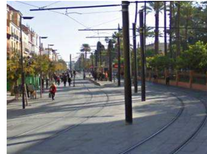
Parada de andén central en Metrocentro (Sevilla)
