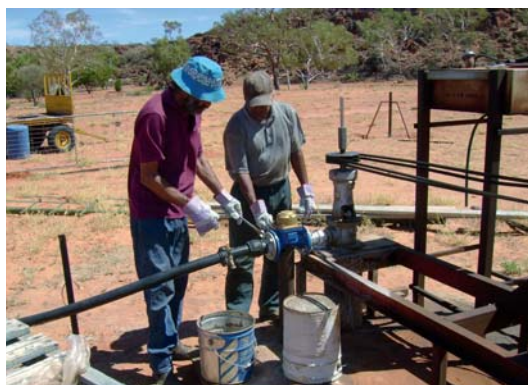
В рамках плана постепенных усовершенствований членами местной общины в Австралии устанавливается водомерное устройство. До разработки ПОБВ у местных жителей не было действенного способа измерять количество воды, которое они расходуют.
