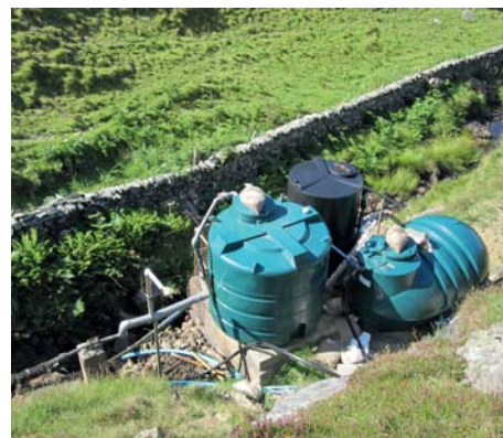
Небольшая коммунальная система водоснабжения, Шотландия. В Европейском Союзе один из каждых 10 жителей (40–50 млн человек) получает питьевую воду из небольших или очень малых систем водоснабжения, в том числе индивидуальных колодезев (Hulsmann, 2005).
