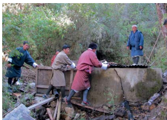
В рамках плана постепенных усовершенствований поврежденная стена имеющегося сборного резервуара для воды (справа) ремонтируется, и одновременно монтируется дополнительный резервуар (слева). Дхаджи, Бутан.
