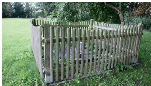
Огражденный колодец в федеральной земле Шлезвиг-Хольштейн, Германия.
