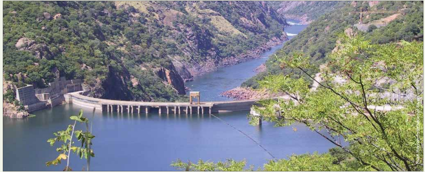
Le barrage de Cahora Bassa dans l'ouest du Mozambique
