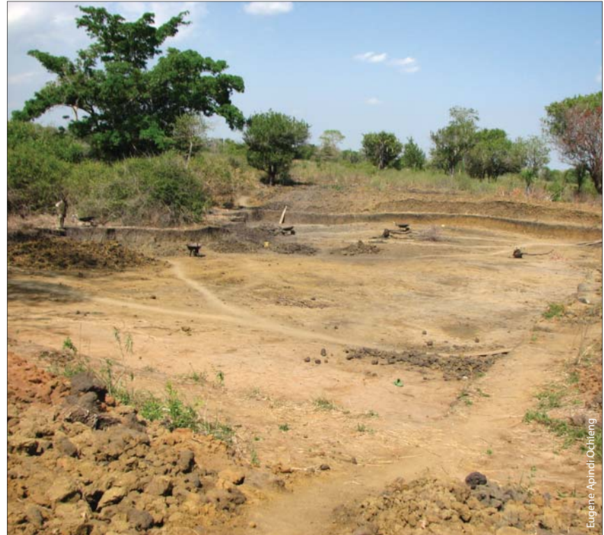
Un étang de collecte d'eau en construction dans le district de Lamu, Kenya
