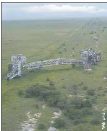
La construction du canal s'est achevée en 1983, et depuis, l'excavateur est resté sur le site
