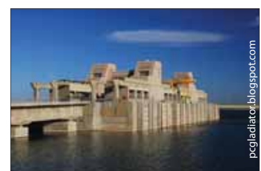
La Station de Pompage Mubarak pompe de l'eau du Canal Nasser et la déverse dans les canaux d'irrigation
