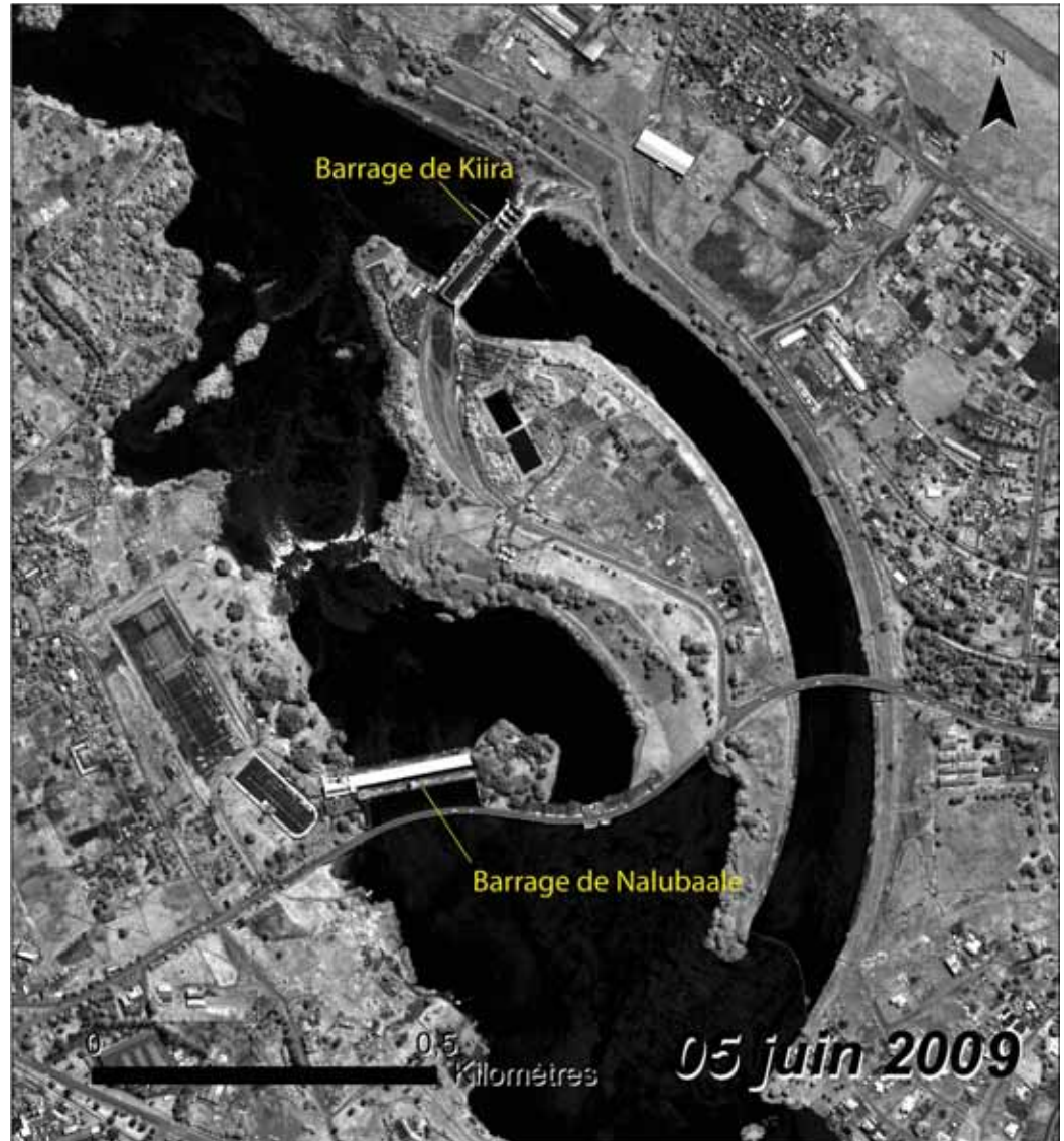
Figure 2.8.7 : Emplacement des barrages de Nalubaale et de Kiira
