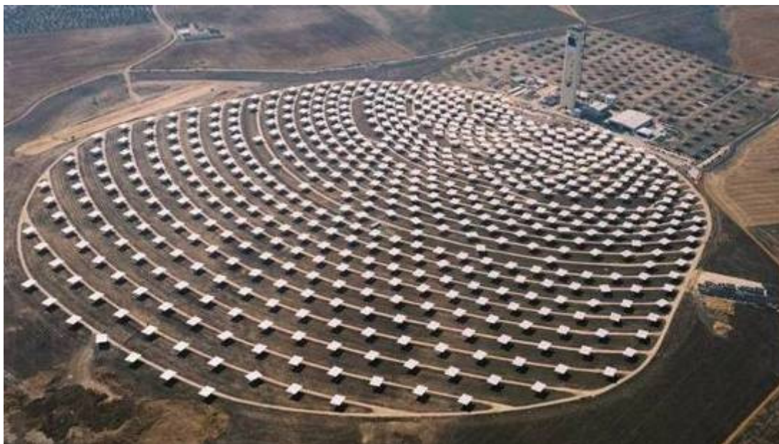
PS10 (ABENGOA); 11 MW e ; Sevilla (España), Marzo 2007
