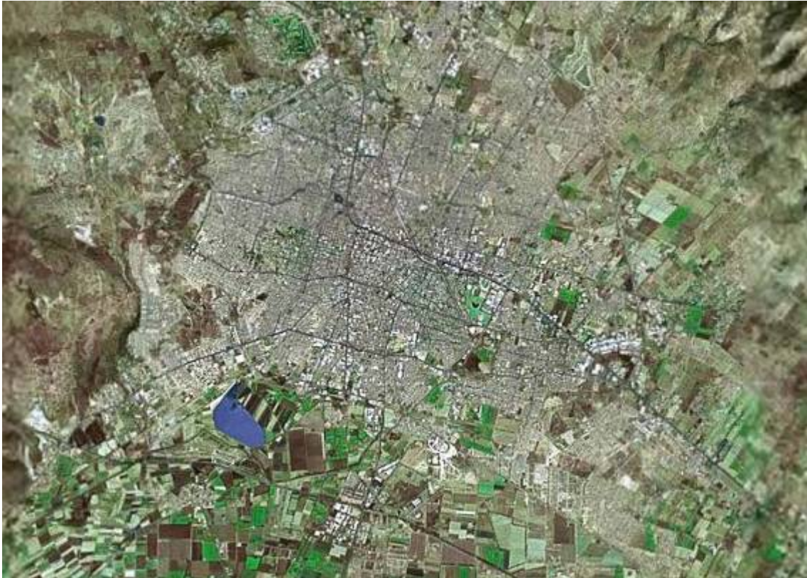
Figura 3.3 Ubicación de la PTAR Municipal
