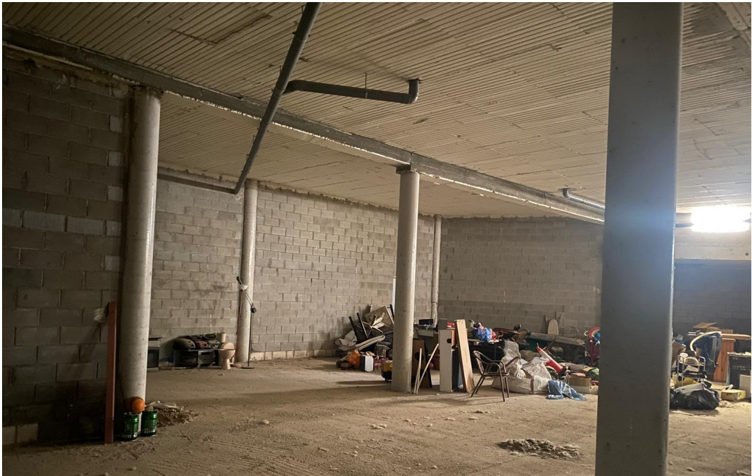
INTERIOR DE LA NAVE.
