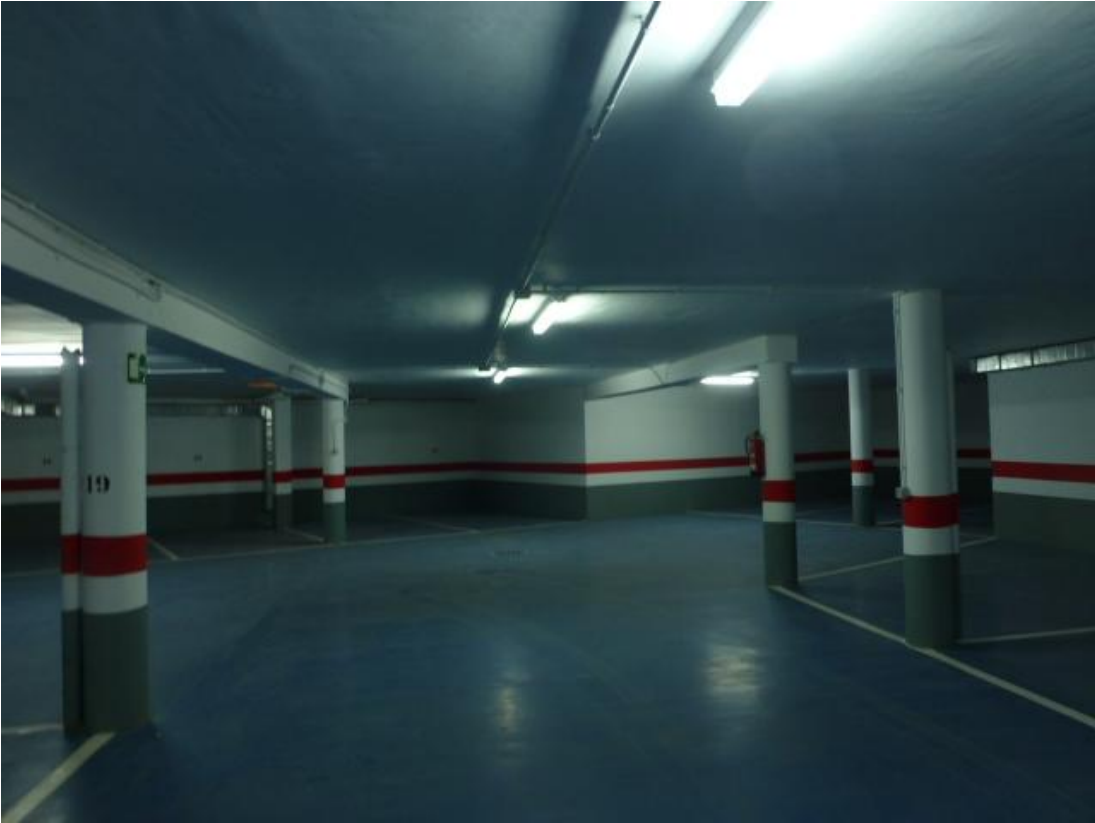
APARCAMIENTO SOBRE EL QUE SE UBICA LA NAVE
