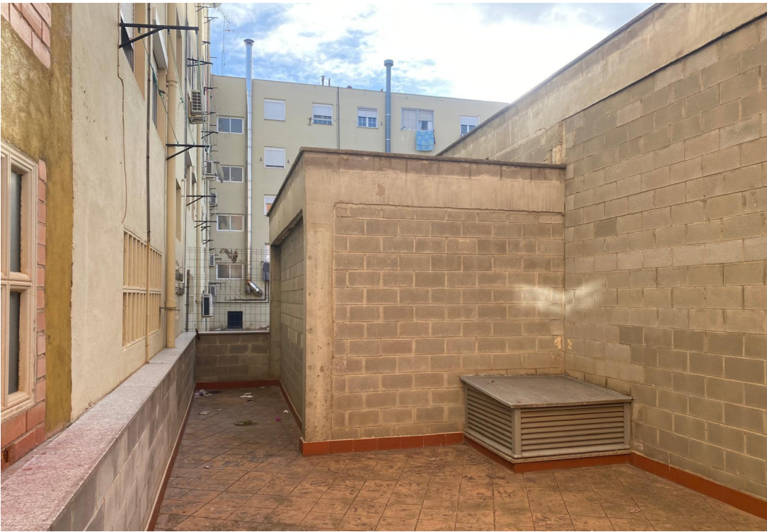
VISTA DE ZONA NORTE DE LA NAVE NAVE.
