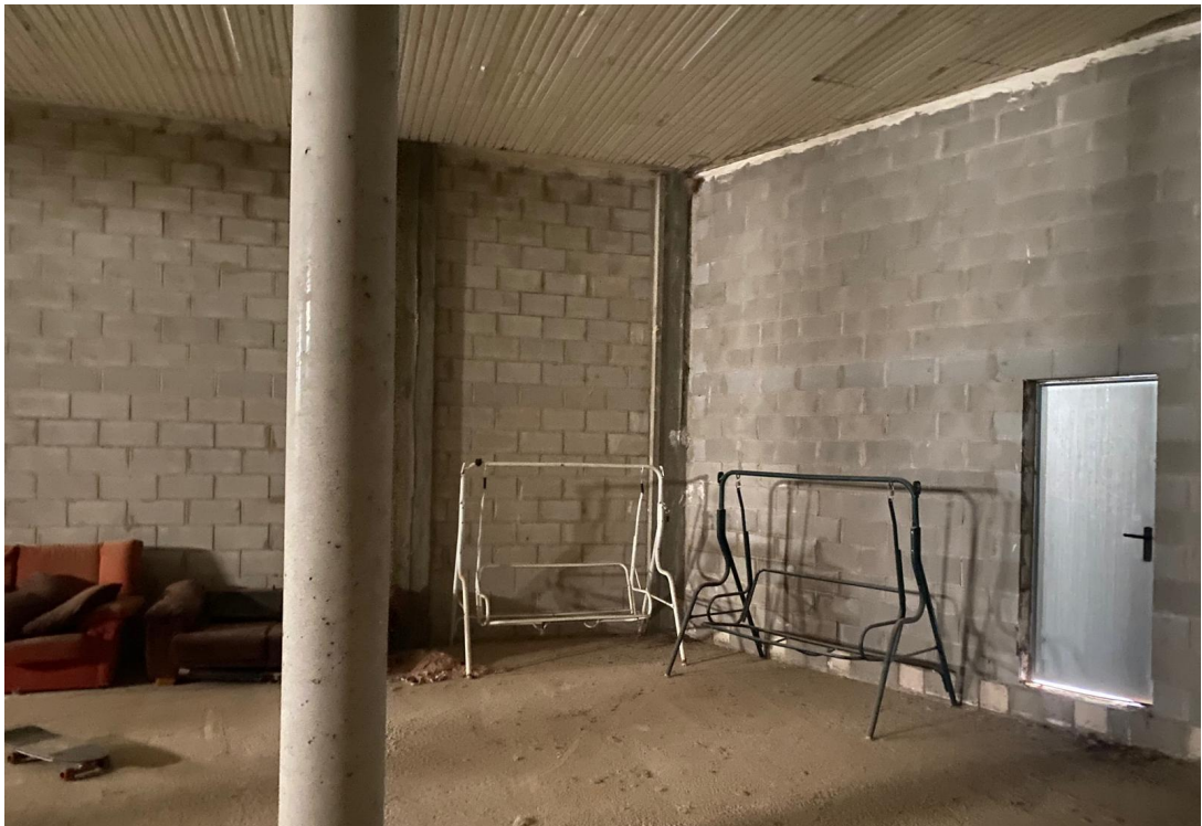
INTERIOR DE LA NAVE.
