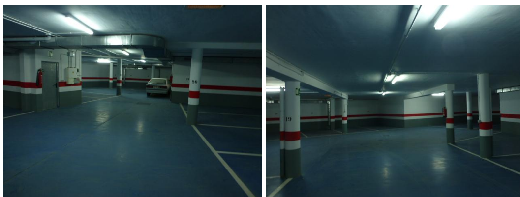
Vista del garaje en planta sótano bajo la nave a demoler.
