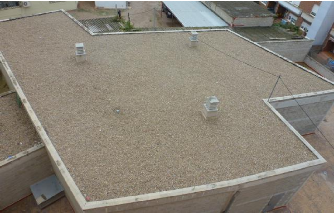
VISTA AEREA DE LA NAVE DESDE LAS VIVIENDAS.
