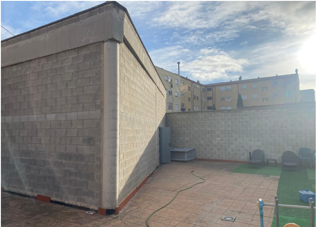
VISTA DE ZONA SUR DE LA NAVE.
