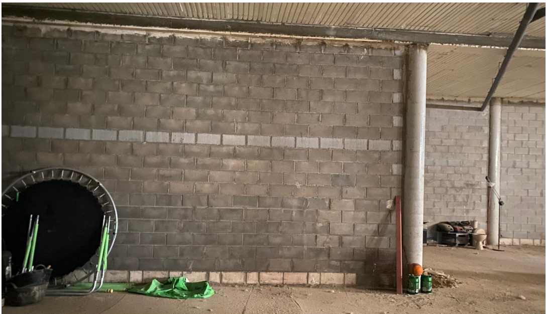
INTERIOR DE LA NAVE.
