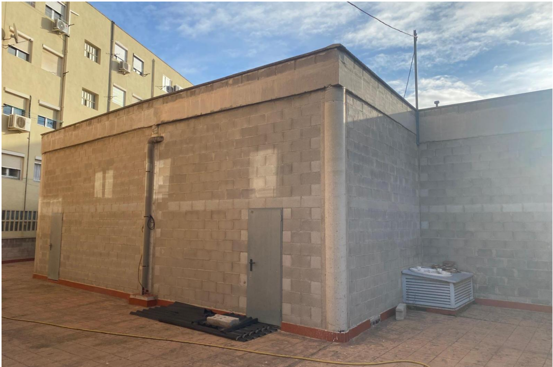
VISTA DE ZONA OESTE DE LA NAVE.
